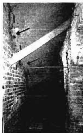
Figura 3: Faglia nel sottosuolo Figure 3: Ground fault evidence
