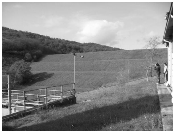
Fig. 1 Diga Astrone ripresa dal paramento a valle. Astrone dam, downstream view
