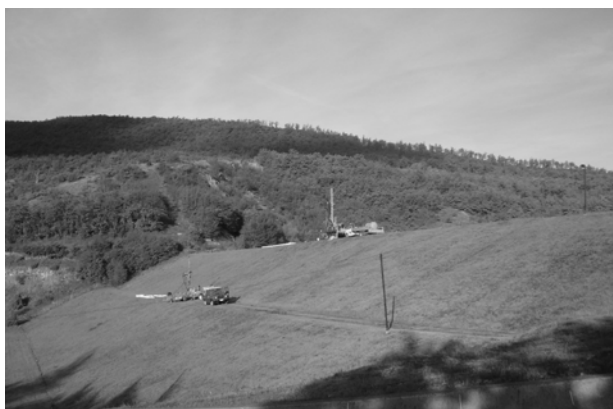
Fig. 2 Sondaggi geognostici. Geognostic soundings
